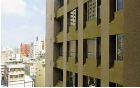
写真15:病棟の外壁。外壁の一部を凹型に彫り込んで、病室の窓を出窓に形成している。もちろん病室に多くの光を取り入れるためにあるが、この設計スタイルは初めて見た。とても面白い。
