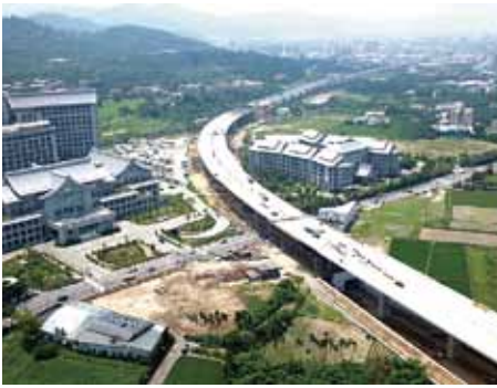
写真9：中央の高速道路（環中東路一段）を挟んで左側が病院本館（第一院區）、右側が別館（第二院區）。道路工事中の昔の写真であるが、2つの建物の位置関係が分かる（写真：交通部臺灣區國道高速公路局の国道視窗 Sep.2012より https://www.freeway.gov.tw/Upload/Html/20129760/page06.html ）。
