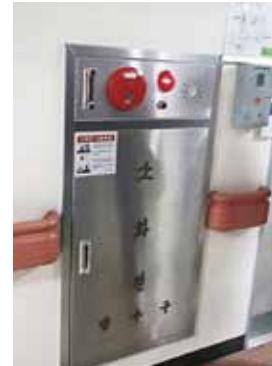
写真23:施設内にたくさんある消防栓。きっと防災訓練も頻繁に行われているのだろう。屋内消火栓は扉を開いてホースを取り出しバルブを回しても水は一滴も出でこない。水は上水道から来るのではない。消防栓箱の赤押釦スイッチを押すと火災報知のベルが鳴るだけでなく、非常用自家発電設備に繋がった消化ポンプのモーターが起動する。消防栓のバルブを回すと受水槽に貯められている水がホースに流れ込んで来る。なるほど。そのシステムを最近まで知らなかった消防栓の扉を開いてノズルを持ち出すと自動的にポンプが起動する病院用簡易式の2号室内消火栓もある。
