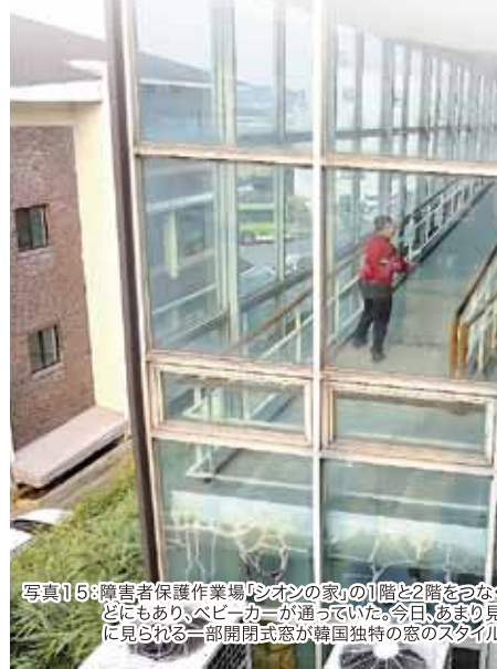
写真15: 障害者保護作業場「シオンの家」の1階と2階をつなぐスロープ。ひと音前にはスロープはよく見かけた。大型スーパーなどにもあり、ベビーカーが通っていた。今日、あまり見かけなくなった。エレベーターだけの時代になったのだろう。写真に見られる一部開閉式窓が韓国独特の窓のスタイル。病院の病棟の窓も多くはこのスタイルだった。
