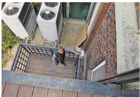
写真17: 障害者保護作業場「シオンの家」の2階と1階を繋ぐ車いす移動用の野外リフト。リフトには壁が全くないので、作動が始まると建物の壁全体が目の前で垂直方向に動き出し、それはかなり怖かった。日本の鉄道駅には「車いす用階段昇降機」(車いすを載せたかごが階段側面に設置したガイドレールに沿って昇降する設備)もある。あれは実際に乗ってみたら、空中で支えがない中での移動となり、きっと相当の恐怖心を抱くことになる乗り物であろう。
