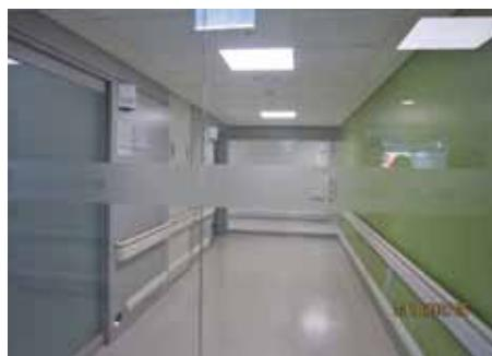
写真27: 院内感染症対策、病棟の一般廊下(写真手前)と前室廊下(中央ガラス扉の奥側)との間はガラスの扉で仕切り、空間を分離している。左側奥は感染症患者用病室(個室)の2部屋。気圧は一般病棟廊下(通常)、前室廊下(やや減圧)、感染症患者用病室(減圧)になり、患者の病原菌が病棟内に拡散しないようになっている。
