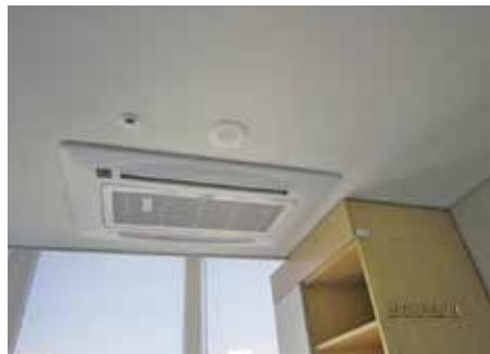
写真30: 陰圧隔離病室の空気給排気器。排気ダクトには特殊な高性能フィルターが装着されているという。2015年、最初のMERS感染者が入院したビヨンテクソム(平沢聖母)病院8104号室は、一つの病室を二つに分割したために排気口が存在しなかった。韓国当局は密接接触者のみを監視対象としていたが、エアコンの排気を通じて8階病棟の滞在者に感染が広がった。さらに最初の患者との密接接触者である家族が香港に飛びMERSがアジア各地に拡散した。韓国病院にはそういう苦い経験がある。
