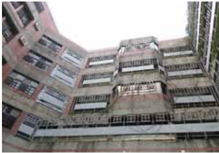
写真4: 屏東は熱帯モンスーン地区である。当然、蒸し暑い。建物内の廊下などの開口部は広く、通気性の良い設計になっていた。転落防止のためであろう、廊下や窓などの開放部には全てファンスが付けられていた。
