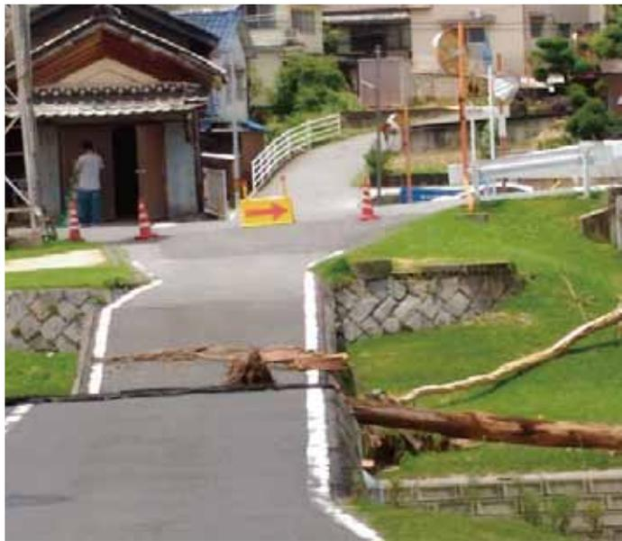
(写真1)本郷川に架かる仲間橋(今津町長波(おさば))。流木の激突で一部崩落。平成30年7月9日撮影。
