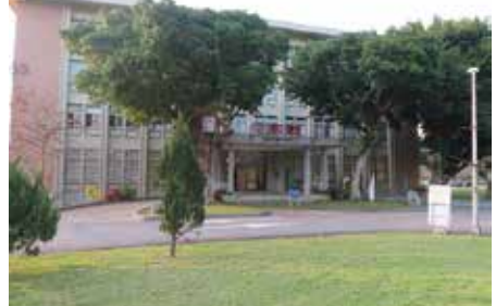
写真9: 旧・國防醫學院圖書館(現・國立臺灣大學檔案館飲水樓)。4階建てで、1、2階が展示室とオフィス、3、4階が國立臺灣大學のアーカイブ書庫になっていた。
