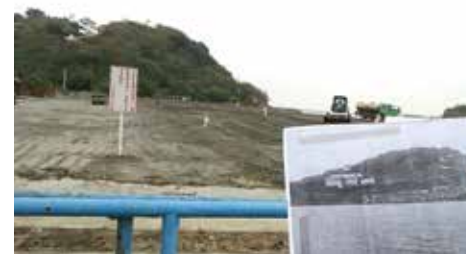
写真5:「慕徳紀念醫院」の跡地周辺(写真3の■印の場所)。造成工事中。林丁國副教授が掲げた当時の写真パネル(右下)には病院と埋め立て前の海が写っている。
