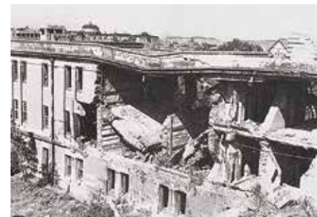
写真2: 1945年5月31日の台北大空襲で被災した臺北帝國大學醫學部附属醫院營養部大樓。後方のドーム屋根は臺北州庁舎(現・監察院)。(写真來源: 國立臺灣大學醫學人文博物館の展示写真より)。
