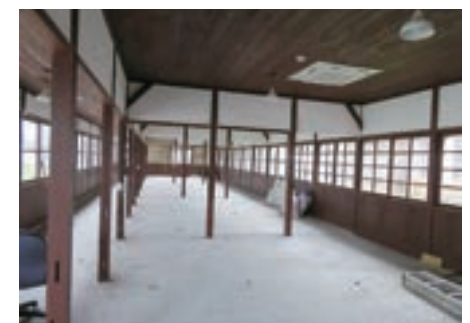
写真12: 花蓮鐵路醫院、病棟内部(改装工事中)。1983年まで病院として使用された。
