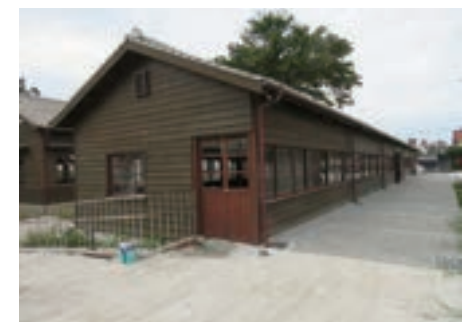
写真11: 花蓮鐵路醫院、病棟址。このような病棟が何棟か並んでいるのである。病院敷地内には防空壕跡もあった。
