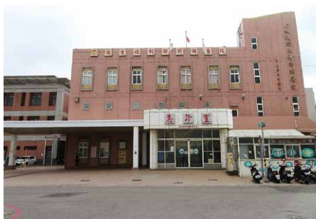
写真8: 急診室(ER)。台湾の病院は一般門診(=外来)と急診との2つの玄関がある。衛生福利部の病院なので、国旗(青天白日旗)が掲揚されている。中央上の看板は「衛生福利部澎湖醫院」であるが、右側の壁の病院名は2013年までの旧姓「行政院衛生署澎湖醫院」のまま。お金に余裕はなさそうだ。
