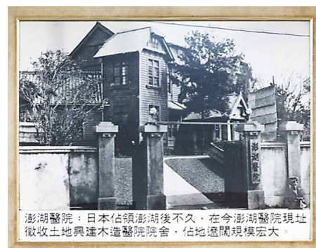
写真2：日治時代(1895-1945年)の澎湖醫院。本館は事務局と薬局が使用し、本館の後方に2棟の病棟が配置された。樹木を本島から移植している(出所：澎湖醫院の院内掲示写真)。
