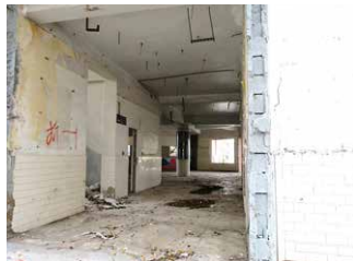
写真4: 写真3の玄関ホール。往訪時、建物は改築・撤去工事の最中だった。
