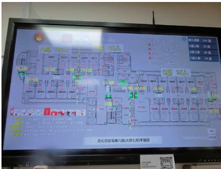
写真7: 病院災害コントロールパネル(平時時)。
