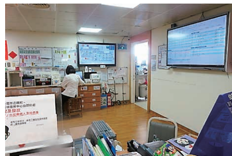
写真6: 8階ナースステーション(護理站)の火災避難モニター(中央壁面)と火災発生時の職員の担当表モニター(右側壁面)。
