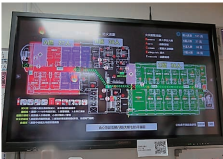
写真8: 病院災害コントロールパネル(火災発生時)。
