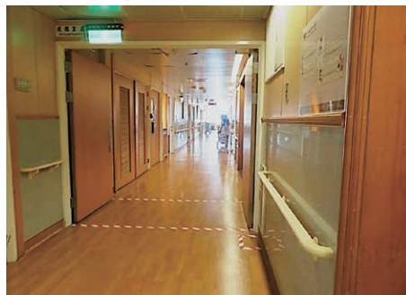
写真4: 8階病棟廊下。上方に緑色の「非常口」表示。廊下天井にスプリンクラー、廊下床面に「防火戸、消火器の前に物を置くな!!」の赤白ライン。床面にいろいろ表示があるのが台湾の病院。
